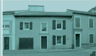
MANOM, GRAND'RUE, Ferme datée 1743 dont la gerbière est toujours visible (porte située au-dessus de l'entrée permettant d'entreposer les récoltes dans les fermes ne comportant pas de grange)
