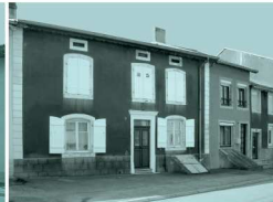
YUTZ, RUE DE LA FONTAINE Maison à linteau délardé en arc segmentaire et entrée de cave sur la rue (début XIX e siècle)
