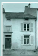
ILLANGE, ROUTE DE THIONVILLE Maison de manouvrier avec linteau décoré et daté 1859
